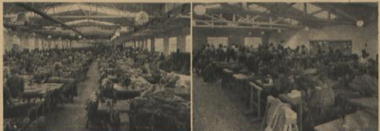
Links der große Arbeitssaal, rechts der kleine Arbeitssaal im ersten Stock des gleichen Gebäudes; hier wird der Klepper-Mantel hergestellt.
