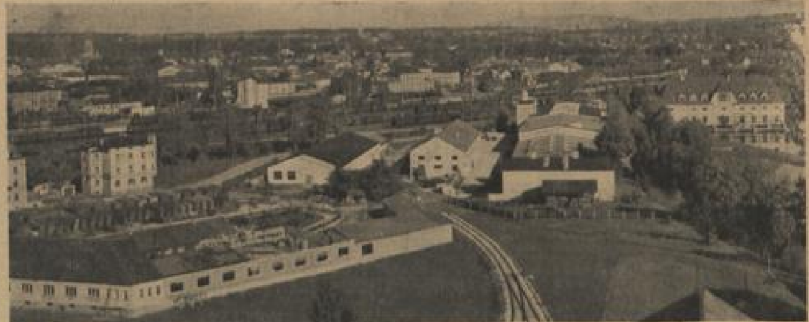
Übersicht über das Werk. Im Vordergrund links das neue Kantinengebäude. Dahinter erkennt man die Baracke mit dem alten Speisesaal und das große Holzlager. Rechts davon die Lagerhalle, daneben rechts das Gebäude mit der Schreinerei und der Dampfmaschine. Dann folgt das große Fabrikationsgebäude mit dem Saal für die Mantelherstellung. Ganz rechts in der Mille ist ein Teil des Klepper-Sees zu erkennen. In dem großen Gebäude am See sitzt u. a. die Verwaltung
