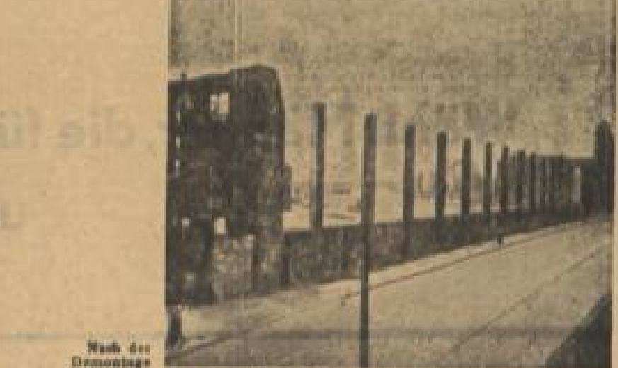
Nach der Demontage
