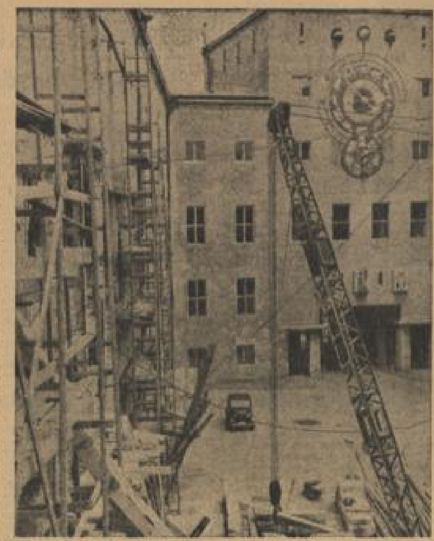
In einem Trakt des Deutschen Museums wird am 1. Okt. das neue deutsche Patentamt untergebracht. Die Bauarbeiten sind noch voll im Gange.
