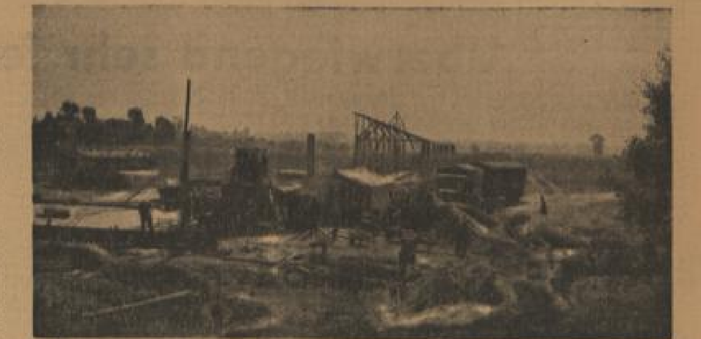
Das Gelände, auf dem die Häuserfabrik entsteht. Im Vordergrund ein Stück der alten gemauerten Straße, über die das Fließband rollen wird. Man beginnt schon mit der höheren Halle. (Das Foto ist einige Wochen alt.)
