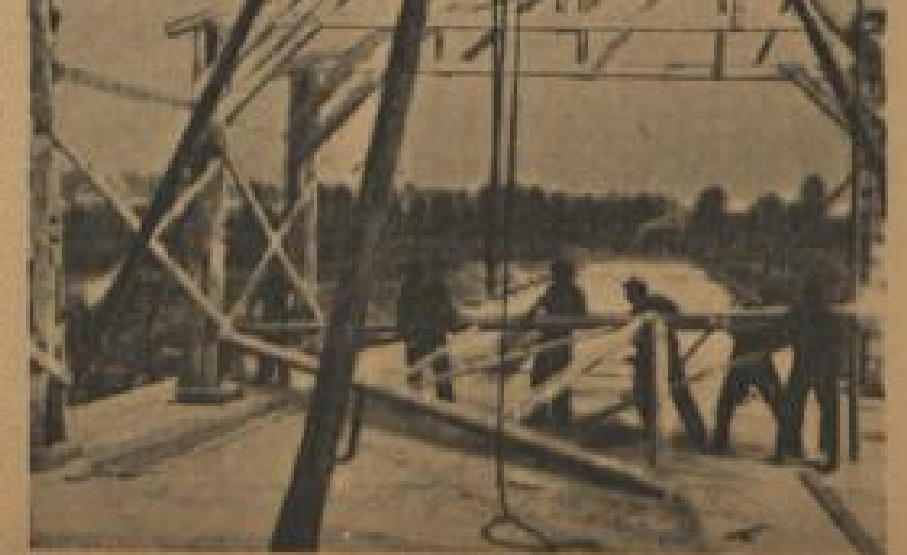
Der 82 m lange Weg, auf dem die Jockers-Platten ihrer Vollendung entgegengehen. Im Bild: Das Gerüst macht schon Fortschritte.
