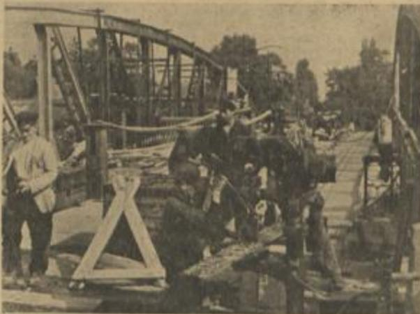
einen Seite durch die Waldorfer Firma Steinmann mit der Pflasterung begonnen, während gegenüber noch an der Stahlkonstruktion gearbeitet wird.
