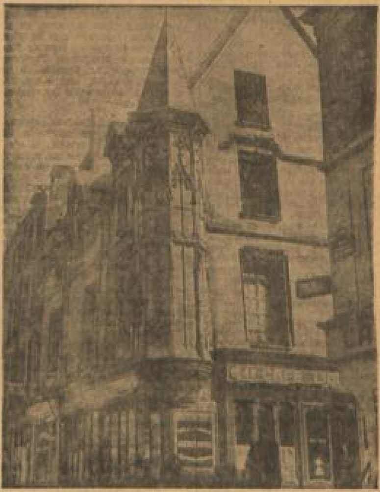
Quand et dédaigne d'une tour de XVème siècle au Village-de-France.
