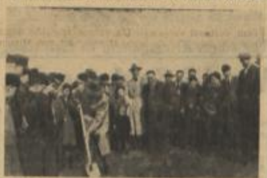
VdK-Ortsvorsitzender Albrecht vollzieht den ersten Spatenstich
