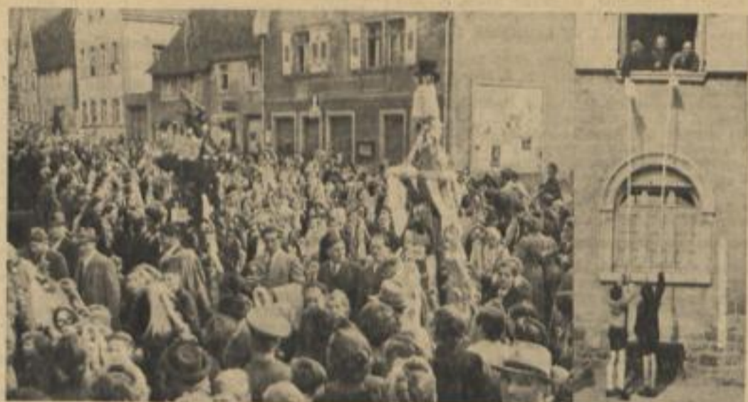
Auch in Rohrbach war alles auf den Beinen — Die kleinen Sammler wußten sich zu helfen
