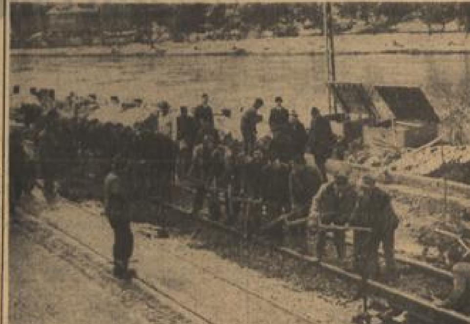
ROHRIG dagegen ist man dieser Tage auf der Bundesstraße 27 zwischen Heidelberg und Schlierbach. Eifrig sind die Arbeiter dabei, die Straße in den Zustand „ohne Schlaglöcher“ zu versetzen. Den jeder Kraftfahrer gebührend zu schätzen weiß, in den Zustand „ohne Schlaglöcher“. Man hätte die „Autofahrer“ lange Jahre „genossen“, nun soll es bis Weihnachten damit ein Ende haben. Keinem zu glauben... Foto: Lebeck
