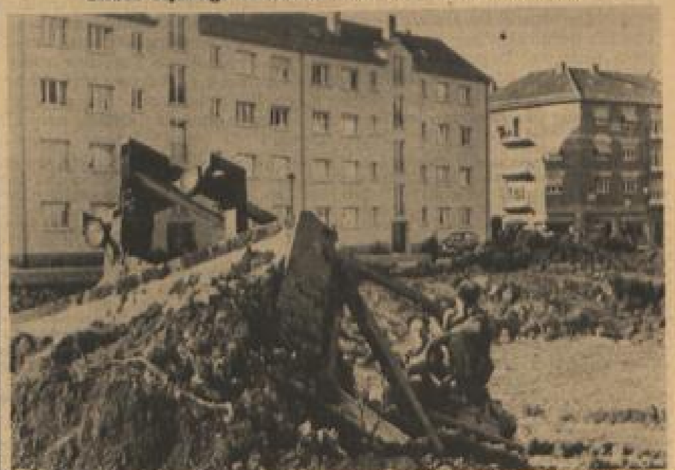
KEIN KIPPER ist das, sondern die Räumschaufel einer riesigen Planiertruppe. Die Amerikaner haben sie unserem Gartenbauamt zur Verfügung gestellt. Aufn.: Speck
