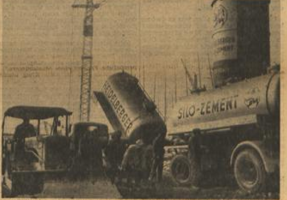
Mit Schwung und Tempo begannen die Arbeiten im Gelände des Hegenichhofs
