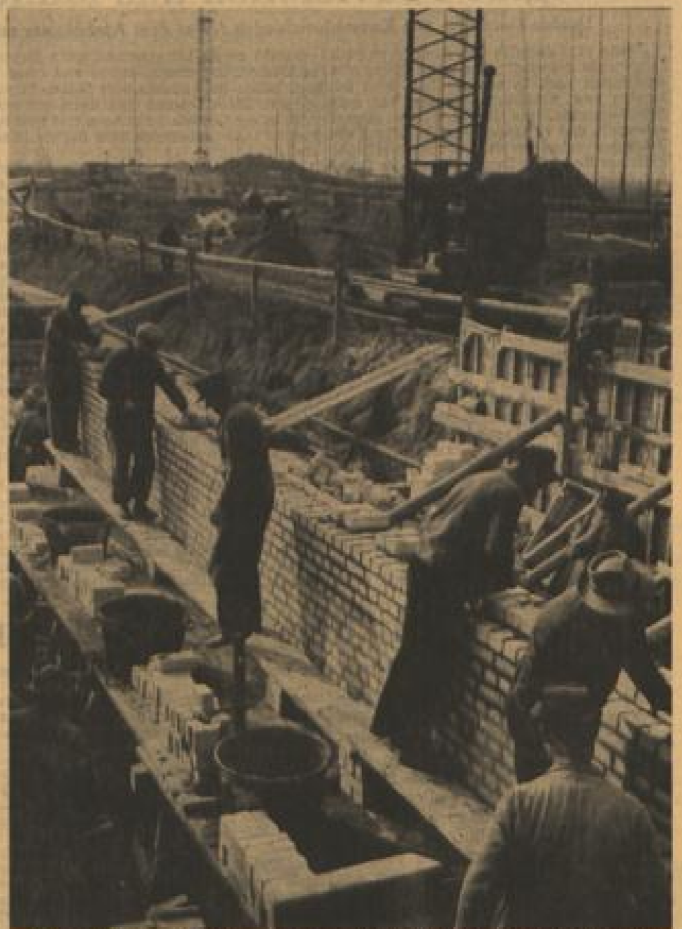
Die ersten Keller sind ausbetoniert und bald beginnt der Mauerneinsatz der Maurer
