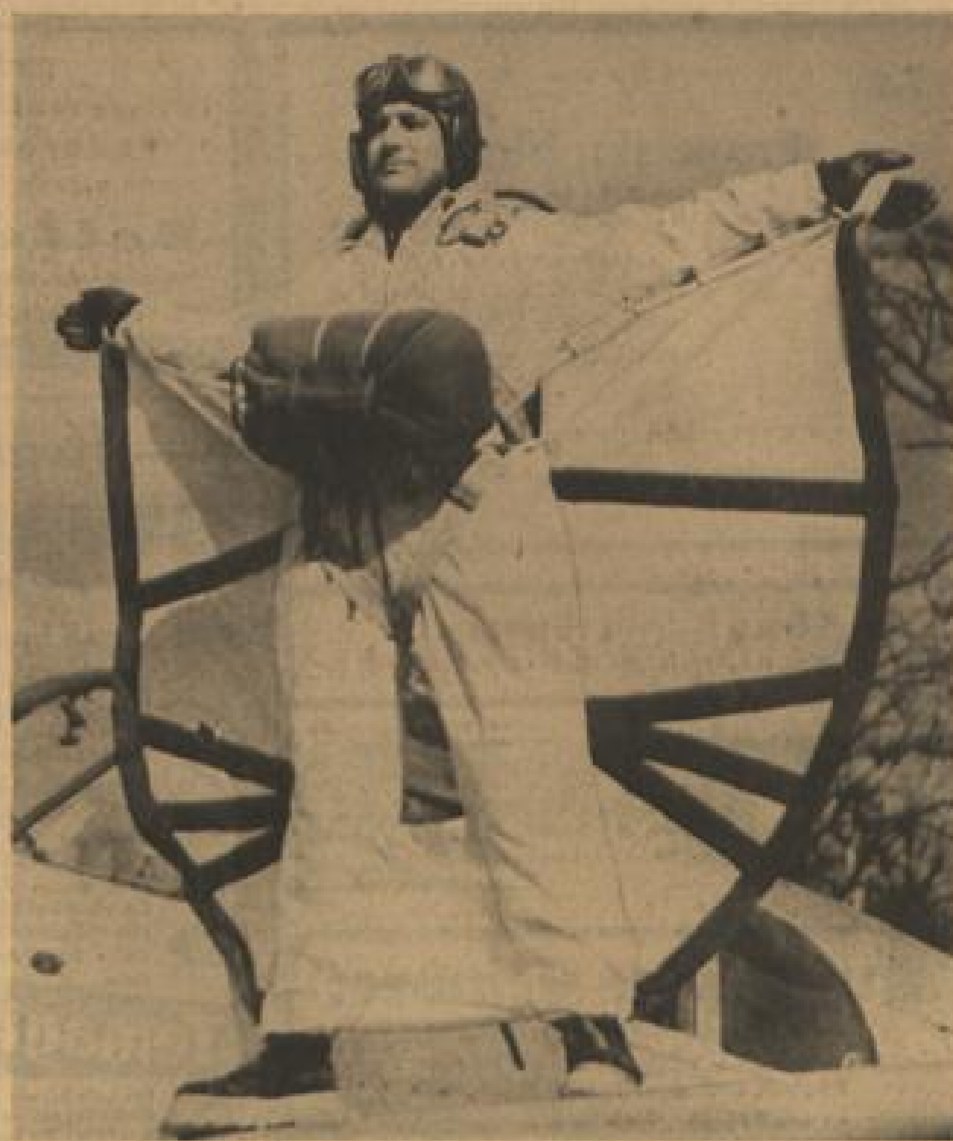
Das ist der „Vogelmensch“ Leo Valentin, der, wie wir in unserer Sonntagsausgabe berichteten, bei Paris über eine Strecke von fünf Kilometern durch die Lüfte ruderte. Der Flugapparat des Franzosen besteht aus den 14 Kilogramm schweren Schlingen von 1,62 Quadratmeter Oberfläche, die an einem um den Brustkorb getragenen Stabkorsett mit Scharnieren befestigt sind. Keystone-Bild
