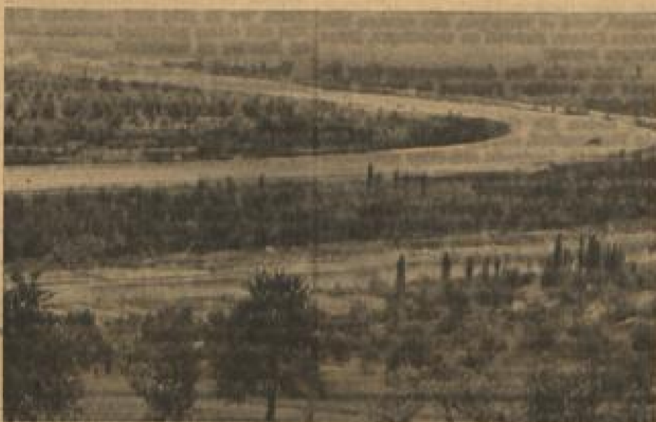
Mit 3,9 Millionen Mark werden die jährlichen landwirtschaftlichen Schäden durch die Grundwasserentziehung beim Bau des Rheinseitenkanals vermindert. Unser Bild, das den Kanal und das Flußbett des Oberrheins zeigt, wurde von einer Höhe des badischen Ufers aus gemacht. Foto: Prager
