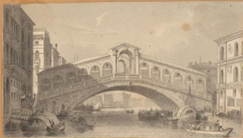
Ponte di Rialto.
