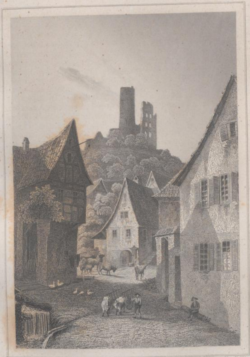
DIE STRASSE VON DER STRACHLENSBURG U. SEHRIBANNEHIMMEL
