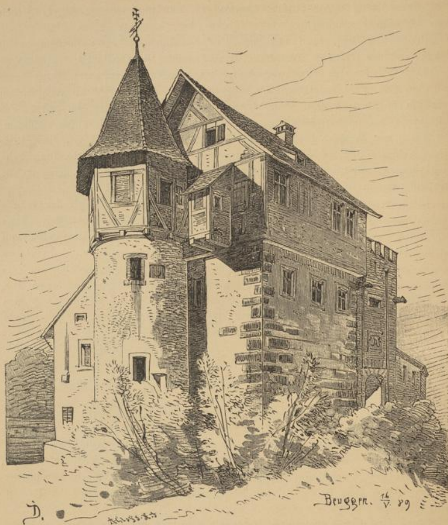
Fig. 7. Beuggen. Brückenhaus, sog. Storchennest. Anbau am Thor.
