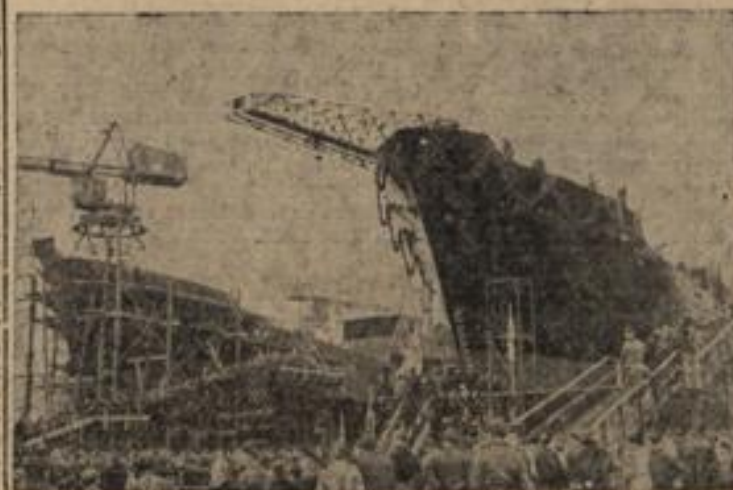
Das erste der 34 von der Militärregierung genehmigten 1949-BRT-Möller, der 40,3 m lang und 11,3 m breite Frachter „Martha Ruff“, lief kürzlich auf den Flender-Werken in Lübeck vom Stapel. Links ein zweites Schiff der gleichen Größe, das Ende Dez. 1949 vom Stapel laufen wird.
