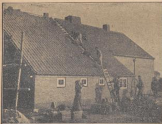
Mit vereinten Kräften wird der neue Hof erbaut.
