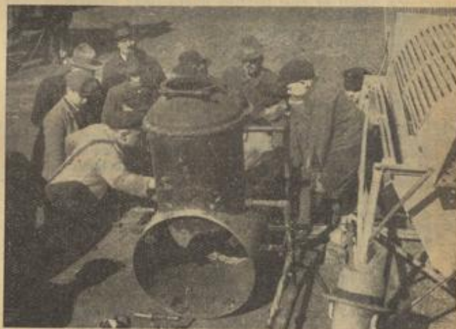
Die genaue Kenntnis von der Zusammensetzung der Landmaschinen und Geräte ist von größter Wichtigkeit für die richtige Handhabung derselben. Hier werden die Teilnehmer eines Kurses über den Aufbau des Vorwärmers einer Dampftrolche unterrichtet. (Aufn. Schaal (2))
