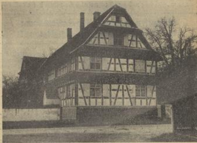
Altes Bauernhaus in Eberöweiler, unweit Rehl
