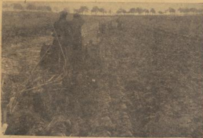
Trotz aller Schwierigkeiten waren vor Beginn des Winters 1940 32 800 Hektar Maginotsteppe in der Gemeinschaftsarbeit des Elsaß umgepflügt Aufn.: Reichsnährstand
