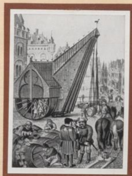
15 Sinnreich konstruierter Kran im 15. Jahrhundert, der mittels eines Tretrades durch Menschenkraft bewegt wurde.
