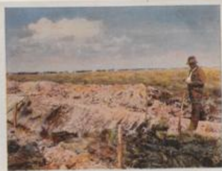
Arbeiten im Moor
