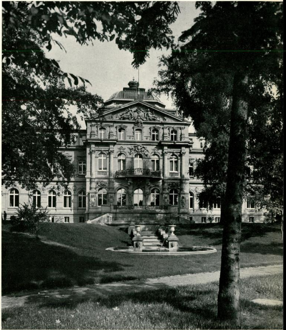
Der Oberste Bundesgerichtshof im repräsentativen Prunkbau des Erbgroßherzoglichen Palais der alten Residenzstadt
