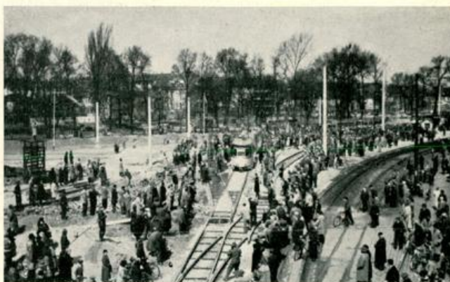
Eröffnung des ersten umgebauten Streckenabschnitts der Albtalbahn am 18. April 1958 in Karlsruhe
