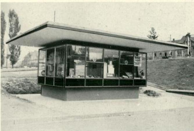
Kiosk in Durlach; Ausführung der tragenden Stahlkonstruktion, der Glaswände in Stahl-Leichtmetall kombiniert und der Schallschluck-Decke mit Kunststoff-Isolierung
