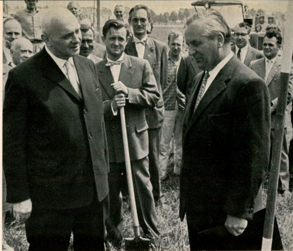
Dr. Gurk beim ersten Spatenstich im Baugelände der Firma Pfizer GmbH.
