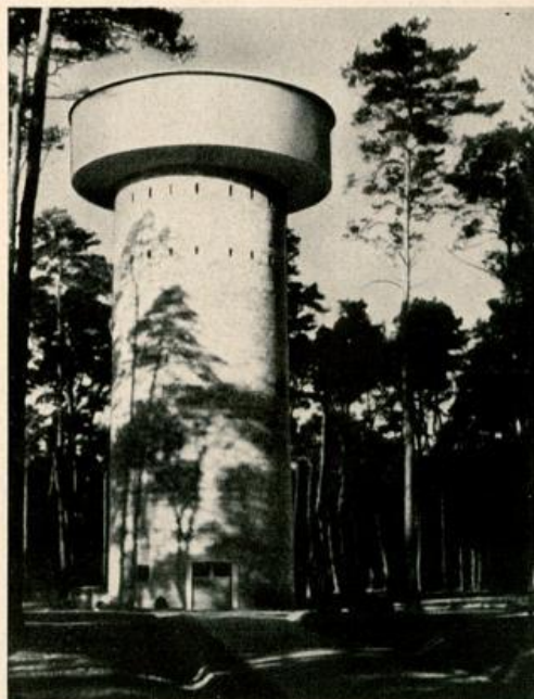
Wasserturm Flugplatz Söllingen
