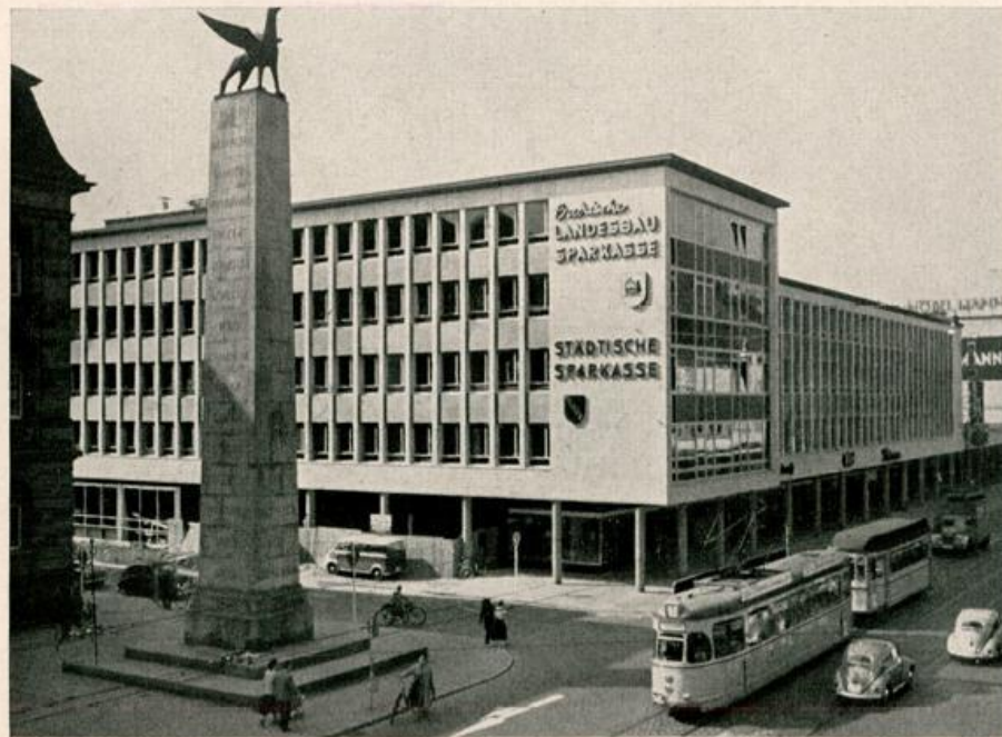
Neubau Ecke Kaiser- und Douglasstraße
