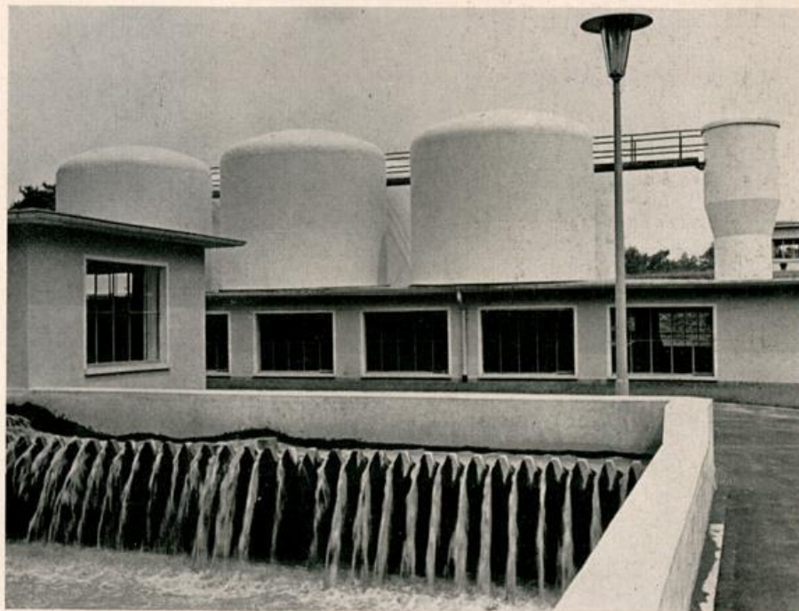
Wasserwerk II Mörsch
