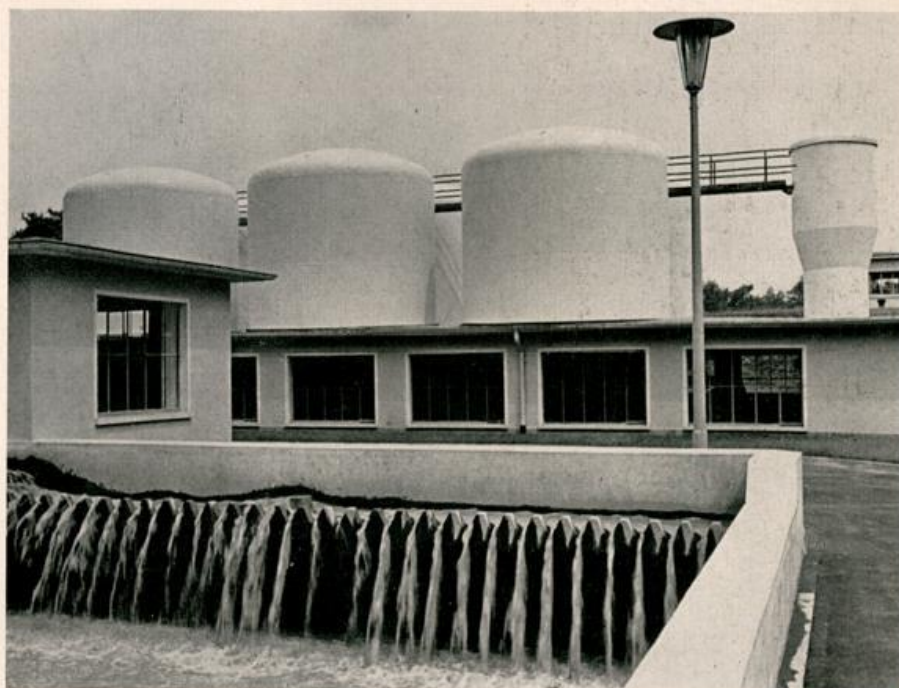
Wasserwerk II Mörsch
