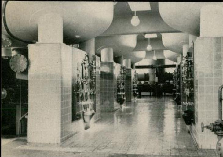
Bedienungsstände der Enteisungsanlage
