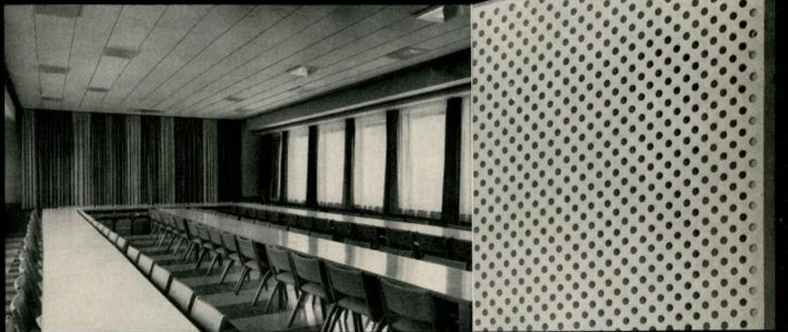
Schallschluckplatte Loch 4,5 und 6 mm
