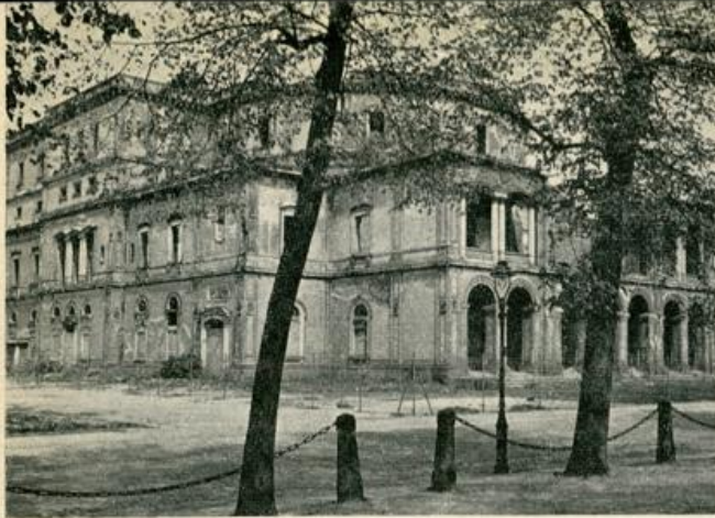
Theaterruine am Schloßplatz
