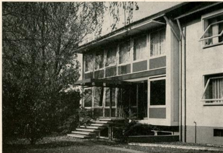
Teilansicht Zentrale Karlsruhe
