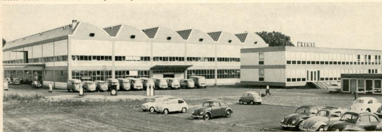
Neubau Färberei Printz GmbH. im Industriegelände Tagweidwiesen
