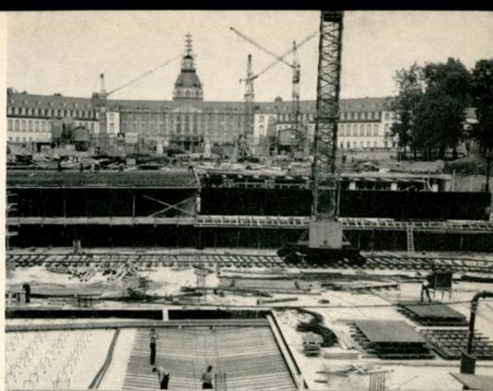
Schloßplatz-Tiefgarage im Bau
